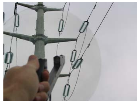
Exemple d'application: pour détecter la présence d'arcs électriques parasites (corona), sur les isolateurs
