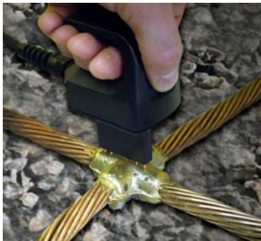
Toma de medida sobre una soldadura aluminotérmica.
