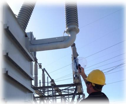
Sensor parabólico para detección de efecto corona
