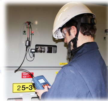
Acoplador bifásico siendo aplicado en un tablero con el detector XDP-II
