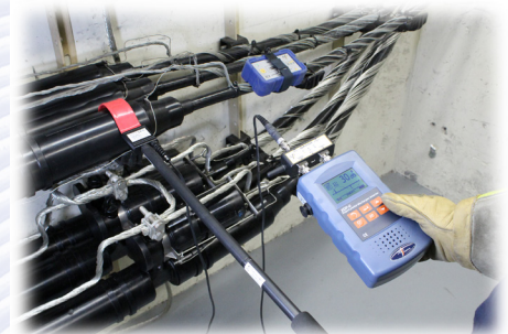
Inspección en campo de empalme en cable
